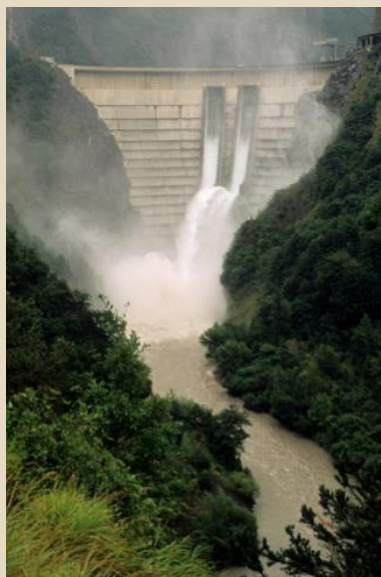
Barrage de Monteynard - © Alain PELLORCE
