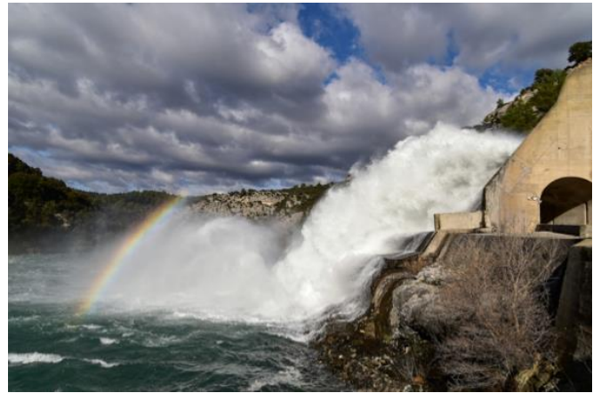
Barrage de Gréoux - © Alain PELLORCE
