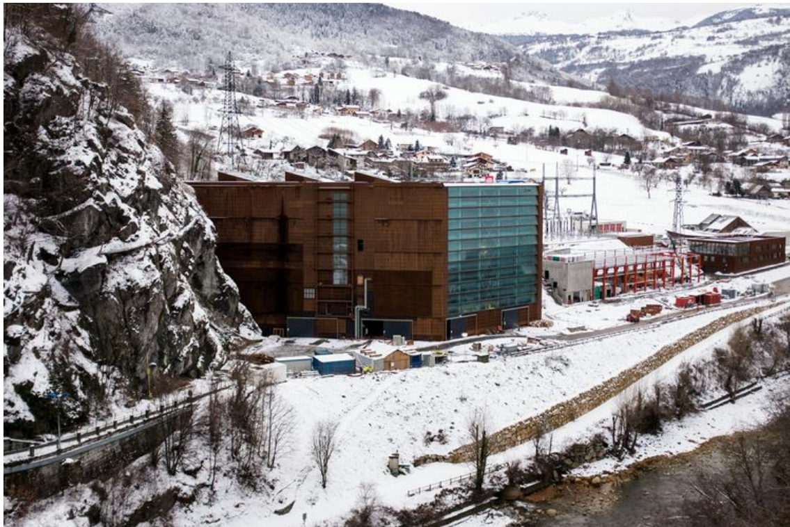
Le site hydroélectrique EDF de la Coche à Aigueblanche en Savoie. Photo Etienne Maury. Hans Lucas pour Libération
