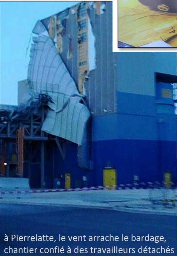
à Pierrelatte, le vent arrache le bardage, chantier confié à des travailleurs détachés
